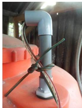
Gambar 6. Bagian luar pemasangan sensor
