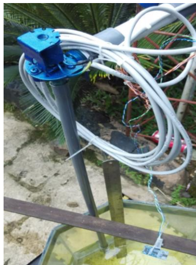
Gambar 3.3 Pemasangan selenoid valve pada tandon
