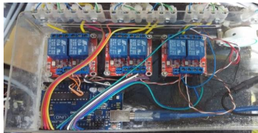
Gambar 3.6 Hasil akhir pemasangan mikrokontroller
